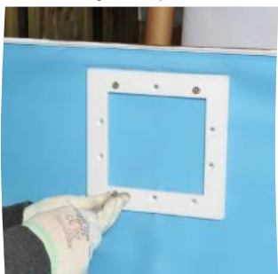
Avvitare il traversino e togliere il liner
