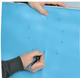
Machen Sie die Schrauben ausfindig und markieren Sie deren Position
