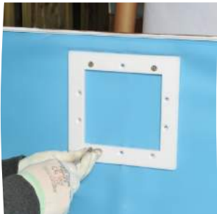
Aparafuse o flange e alieire o liner
