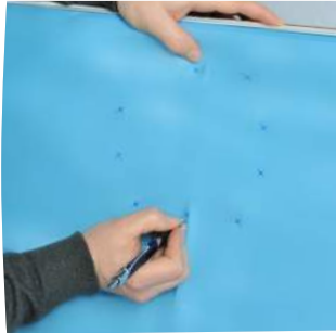
Repérez et tracez l'emplacement des vis
