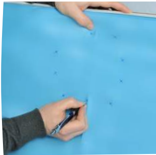
Localize e assinale a localização dos parafusos
