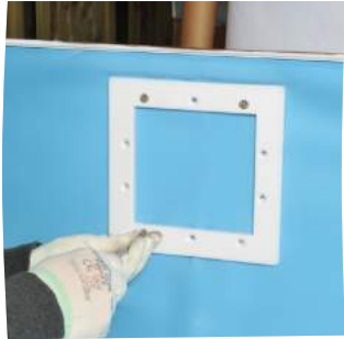
Atornille la brida y ahueque el liner
