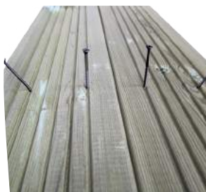
Fixing of the edges Colocación de las playas Fixation des margelles Befestigung der Ränder Fissaggio dei bordi Bevestiging van de randen Fixação dos bordos
