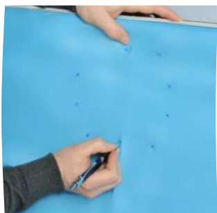
Individuare e segnalare la posizione delle viti
